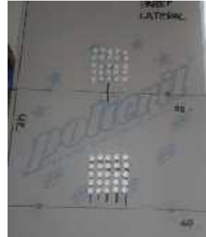
Imatge (41): Forats a la paret lateral dreta
